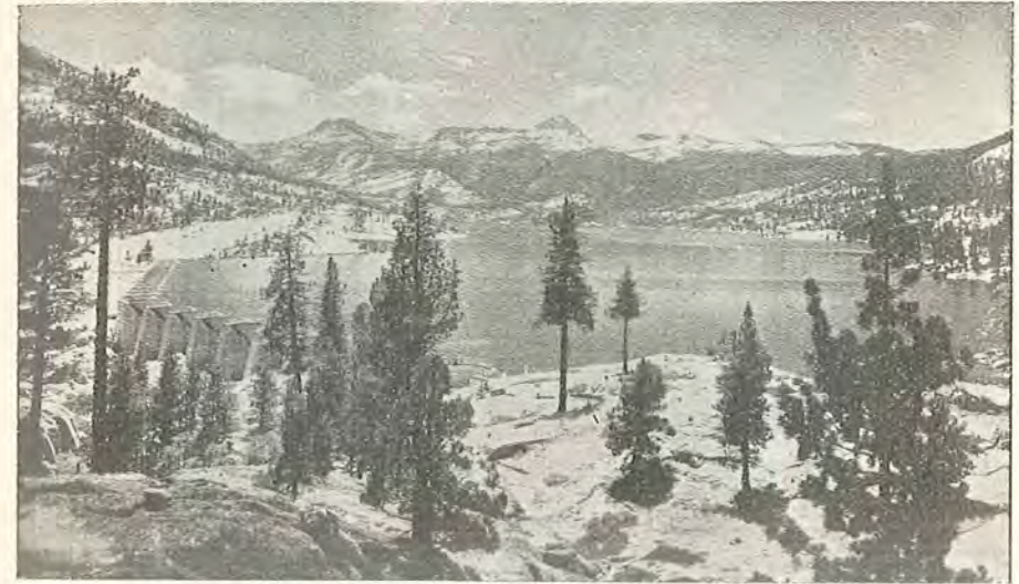
Fig. 2. 12. Florence Lake ligger i 7300 fods højde. Betonen udsættes for indtil 200 frysnings- og optøninger pr. år.
