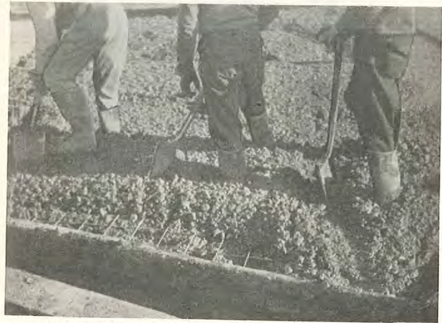
Fig. 2. 6. Støbning af betonvej i Washington D.C. Arbejderne synker ned i den bløde beton.
