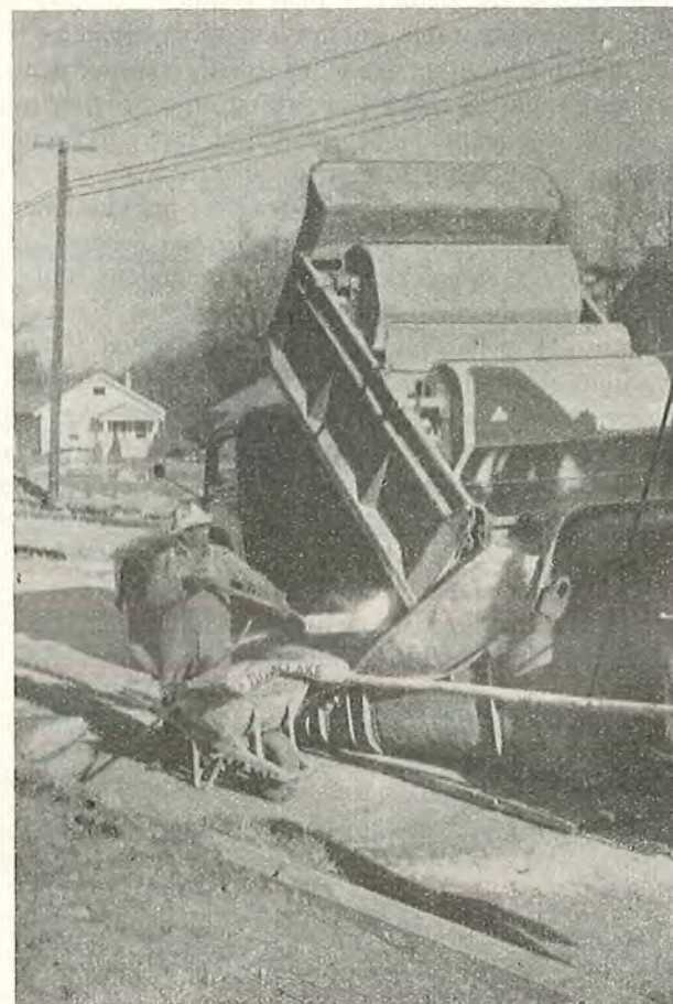
Fig. 2.8. Transportbil med betonmaterialer afvejet i det rigtige blandingsforhold. For at undgå, at cementen optager fugtighed under transporten, opbevares den i særlige trugformede beholdere, der tipper samtidig med, at materialerne løber ned i elevatorspanden. Betonen udstøbtes i november måned, og der tilsattes kalciumklorid for at fremskynde hærdeningen.
