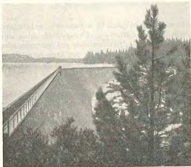
Fig. 2. 14. Spærredæmning ved Shaver Lake bygget i 1927. Dæmningen er 680 m lang og 60 m høj.
